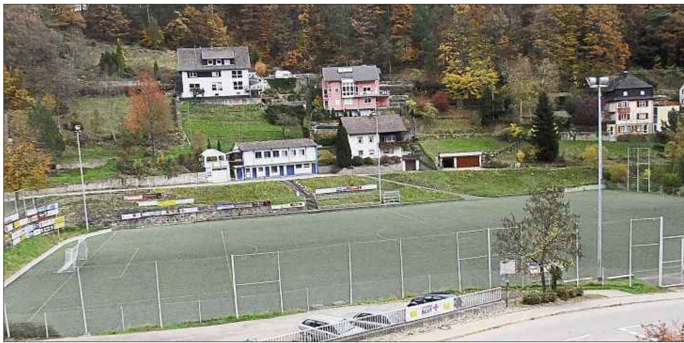
Beim Lauterbacher Sportplatz stehen Sanierungen der Flutlichtanlage und des Sportheims sowie die Namensgebung an. Foto: Borho
