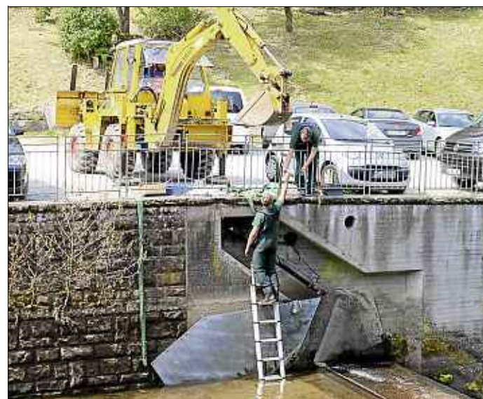
Wegen eines technischen Defekts am St.-Maria-Wehr konnte die Schiltach mehrere Wochen nicht gestaut werden. Foto: Lipp
