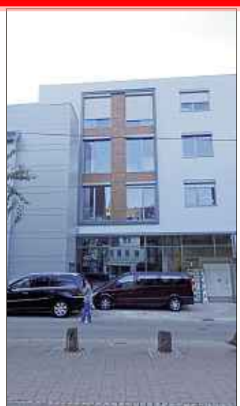
In die neuen Geschäftsräume in der Hauptstraße kommt eine Buchhandlung. Foto: Fritsche
