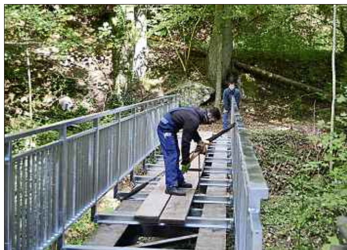
Steht schon: die neue Stahlbrücke über die Berneck auf dem Wanderweg von Schramberg nach Lauterbach. Foto: Kiolbassa
