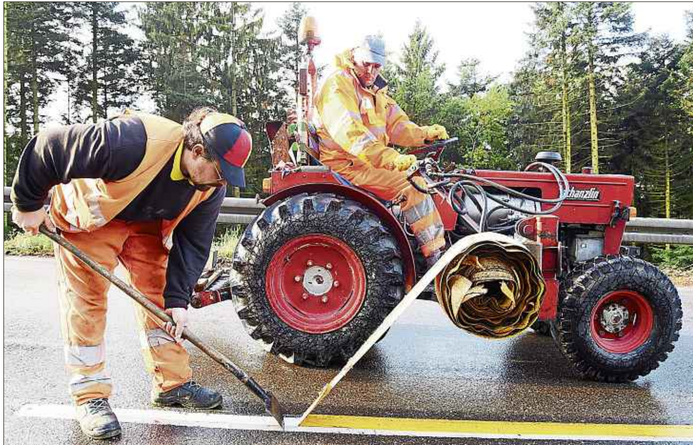
Mit einem Traktor mit spezieller Aufwickelwinde wird die Baustellenmarkierung auf der Bundesstraße entfernt. Möglicherweise schon heute soll auch der Verkehr wieder ungehindert zwischen Sulgen und Schramberg fließen können. Foto: Wegner
